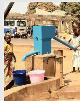
Remplacement d'une pompe cassée par la solide BluePump.
